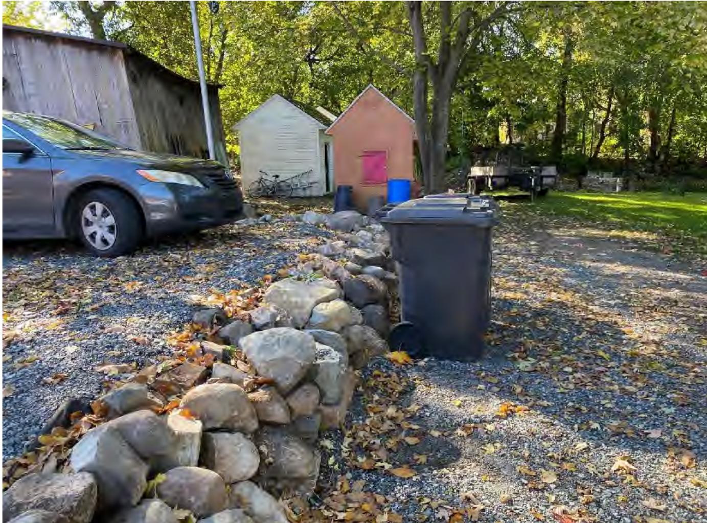
Remplacement du muret existant et prolongation avec des boulders guillotinés
